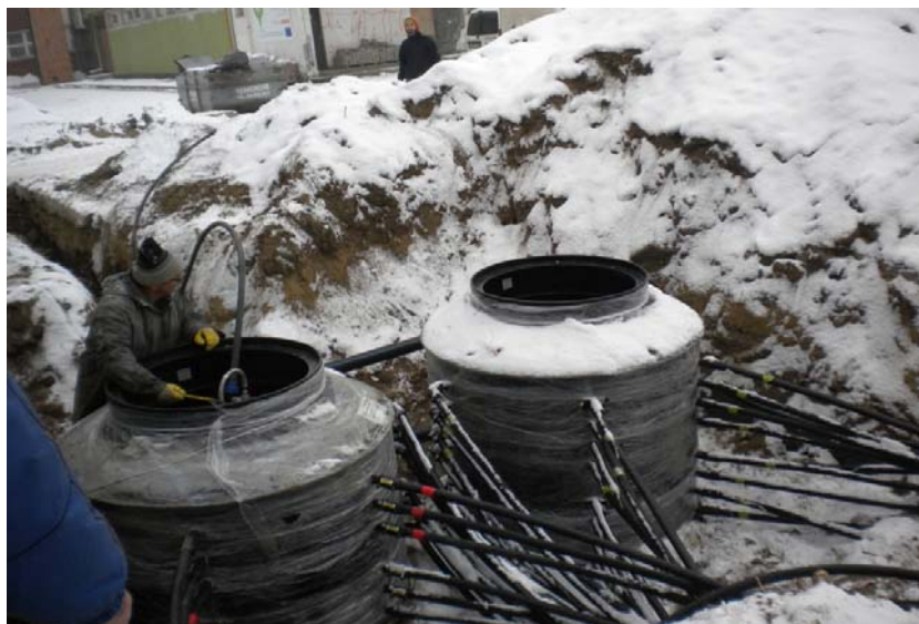
4. fotó Gyűjtővezetékek szerelése
