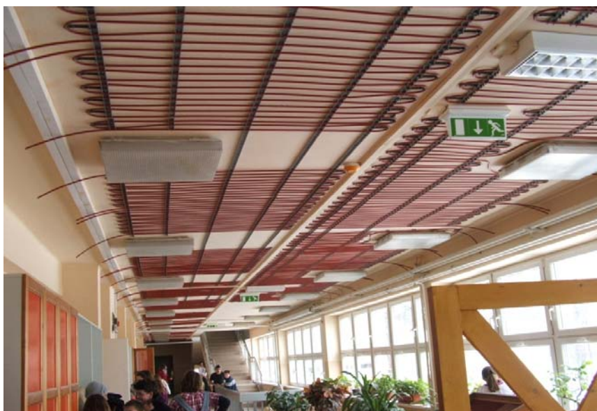
6. fotó Iskola folyosóinak mennyezetfűtés csőregisztereinek felhelyezése
