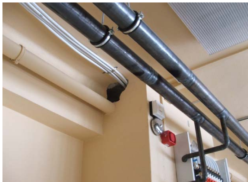
7. fotó Fűtési osztógyűjtők és csővezetékek kiépítése
